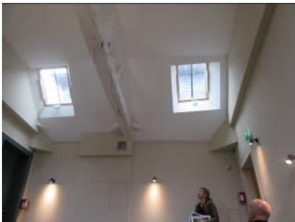
Installation d'un système de désenfumage
