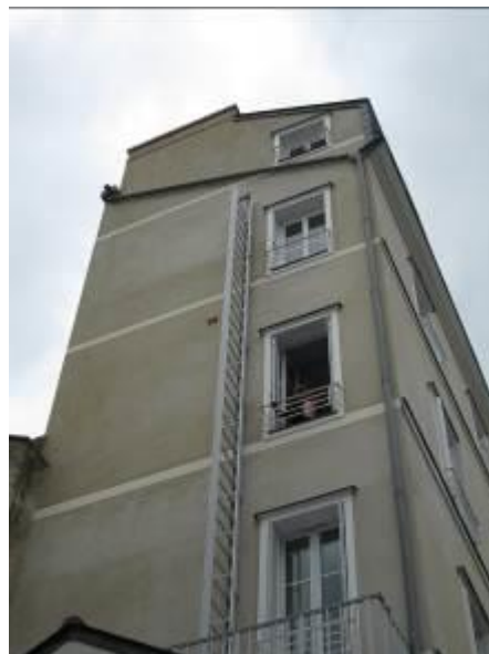
Installation d'une échelle Jomy
