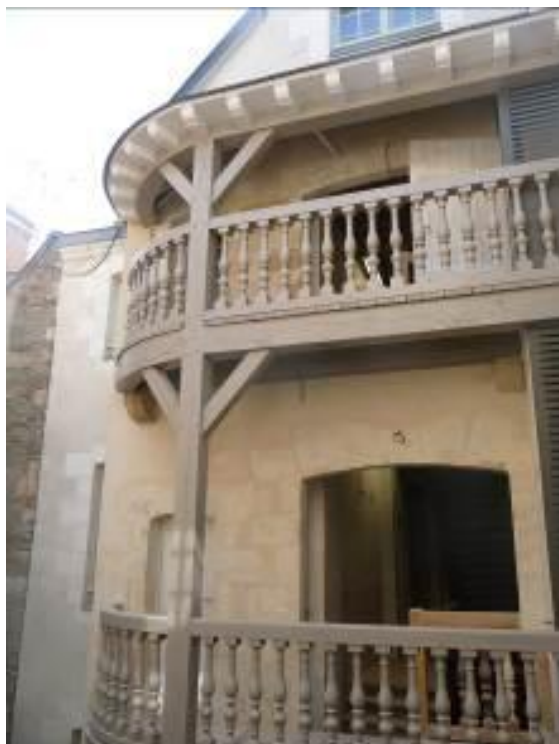
Réalisation d'un espace d'attente sécurisé
